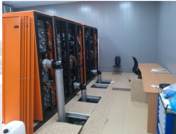
Твёрдотельный ВЧ генератор для ускорителя NILAC, ОИЯИ
