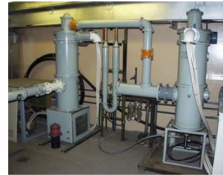
Двухкаскадный генератора на триодах GI-50A
